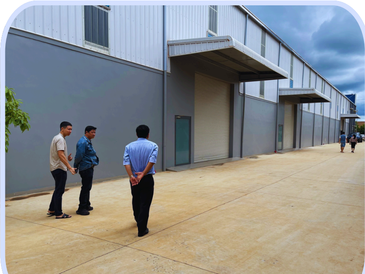
XUỞNG SẢN XUẤT BÁNH MÌ HÀ NỘI Tp. Buôn Ma Thuật, Tỉnh Đắk Lắk
